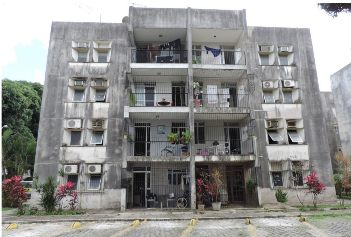
Foto 17 – Exemplo de fachada com S_w > 20\% (fachada FC3S, com S_w = 20,17\% )
