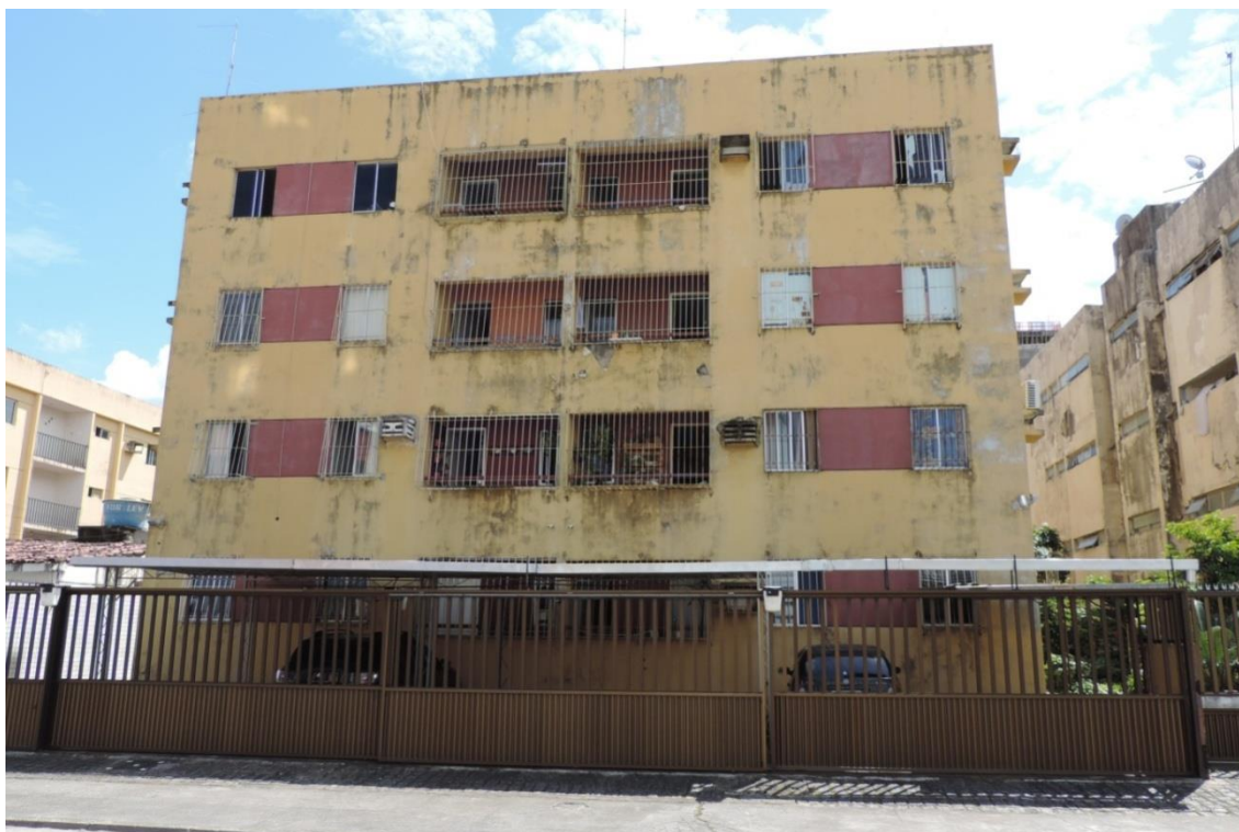
Foto 16 – Exemplo de fachada com S_w > 20\% (fachada FL1L, com S_w = 22,40\% )
