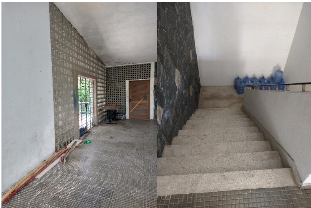
Figuras 48 e 49: Hall Primeiro Pavimento e Escada. Fonte: Autora, 2024.
