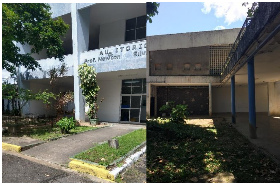
Figuras 38 e 39: Fachada Leste e Fachada Sul. Fonte: Autora, 2024.
