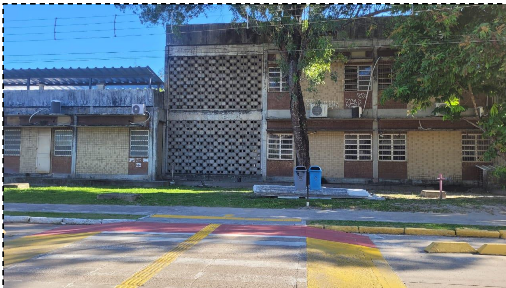
Figura 11: Situação atual da Fachada Norte do prédio do DQF/CCEN evidenciando a árvore existente.
