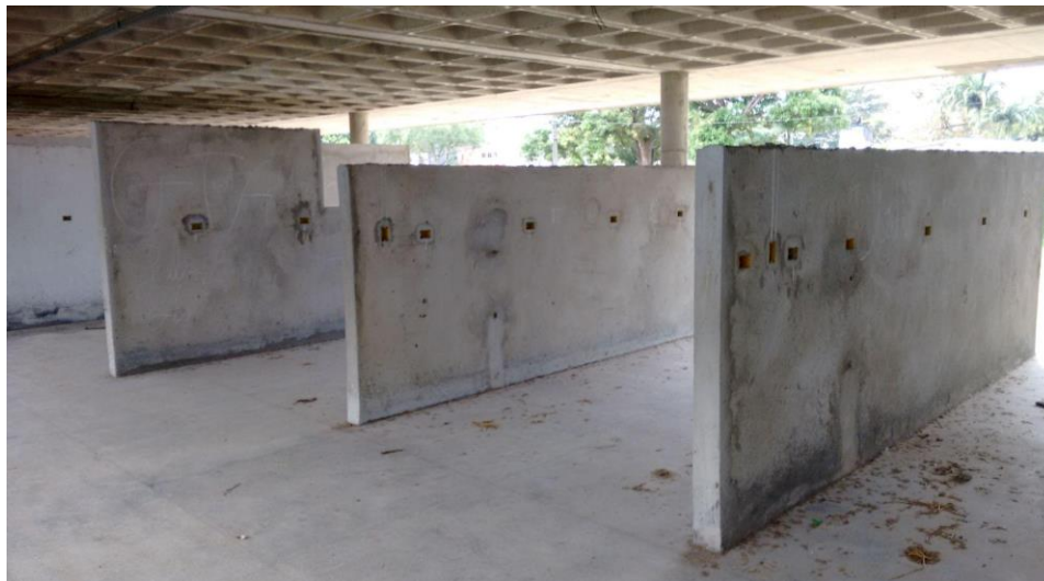
Figura 23: Vista interna do bloco B. Fonte: o autor.
