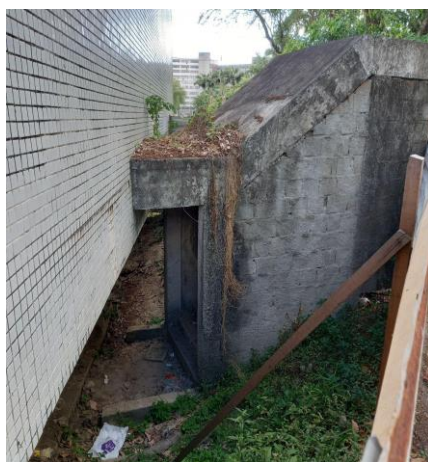
Figura 25: Escada de acesso ao pavimento semienterrado do bloco B que será concluída. Fonte: o autor.
