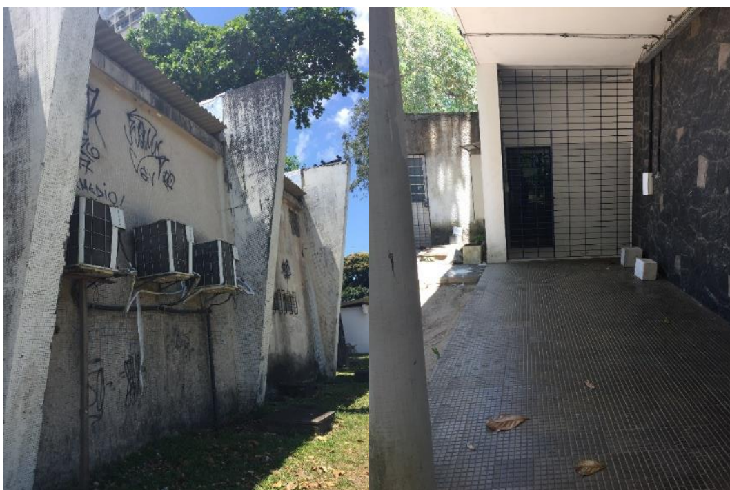
Figuras 46 e 47: Fachada Oeste e Escada. Fonte: Autora, 2024.
