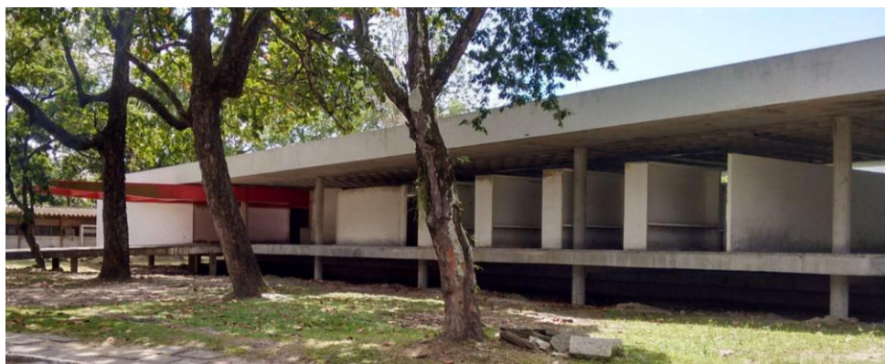
Figura 22: Fachada Oeste onde vemos as paredes internas do bloco A que serão demolidas. Fonte: o autor.
