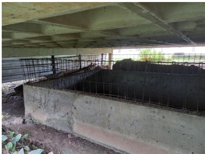
Figura 24: Pavimento semienterrado do bloco B que terá as paredes complementadas. Fonte: o autor.
