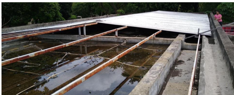
Figura 26: Coberta que será reformada. Fonte: o autor.
