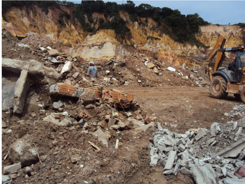
Figura 0.4 – Foto da zona de segregação tendo à esquerda RCD vermelhos e à direita, RCD cinza
